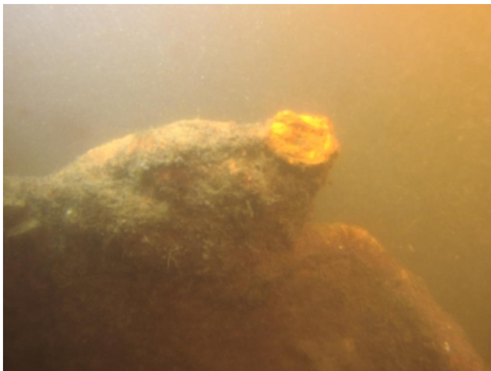
Obr. PS, a.s. vyčnívající štětovnice na DO PK
